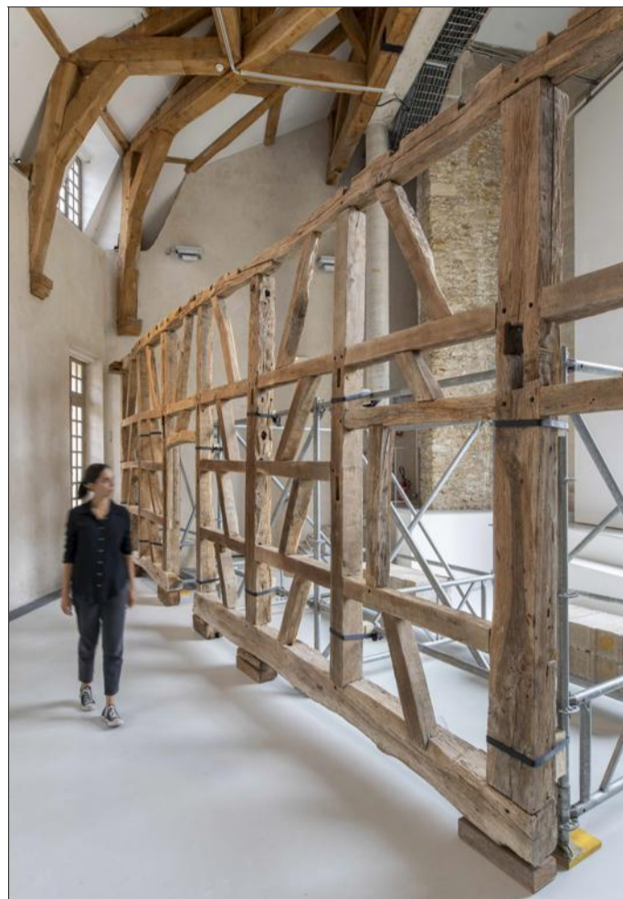
La charpente bressane se mêle parfaitement avec celle de la Maréchalerie, installée dans les anciennes écuries du château de Versailles. Photo Nicolas Brasseur
