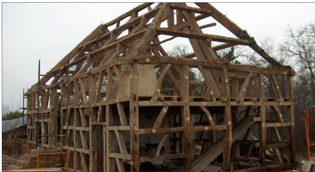
Le collectif Clara a été impressionné par la méticulosité de Pierre Geoffroy, qui a décapé, numéroté, et répertorié chaque pan de bois de manière à ce que la maison soit facilement montée et démontée.
